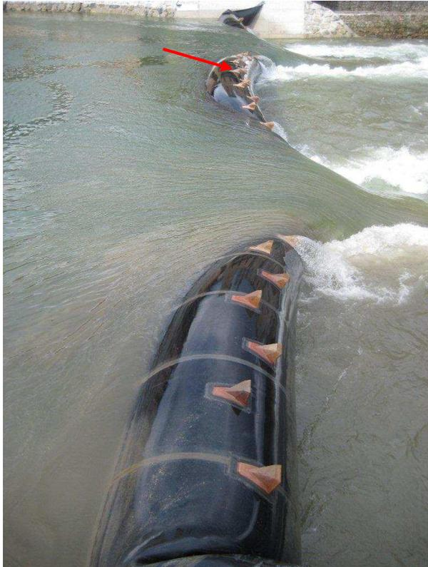
El peso del agua aplasta la parte superior del cuerpo de goma contra la parte inferior del mismo que permanece sobre la losa de cimentación, creando una o varias cavidades herméticas (señalada con una flecha roja en el caso de la foto) que impiden o dificultan al aire retenido en su interior que éste llegue hasta los estribos y alcance el fitting del tubo de aire para salir al exterior.
