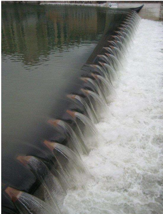
pequeñas burbujas de aire recubiertas de agua que se proyectan con gran violencia contra el hormigón (cavitación) generando desgastes y desconchados en las paredes exteriores del dique. Para evitar este pernicioso efecto se suelen instalar una o varias tomas de aire que comunican este espacio con el exterior, las cuales permiten compensar la pérdida del aire que absorbe el vertido, eliminando la hermeticidad y la cavitación.
