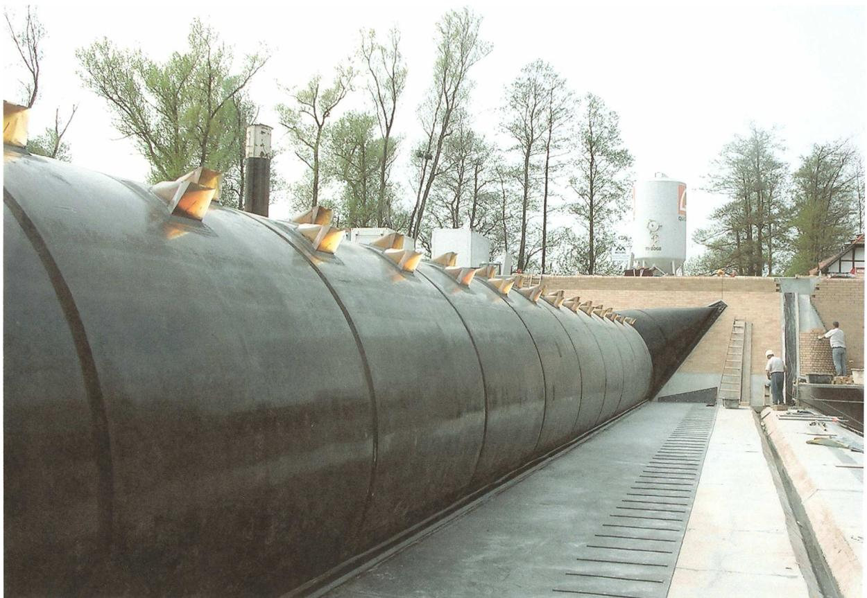
Obviamente, el coeficiente de rozamiento del cuerpo de goma con la lámina antiabrasión es casi cero, porque existe una delgada capa de agua entre ambas superficies; y desde el punto de vista del rozamiento, el agua es para el caucho como la grasa para un rodamiento.
